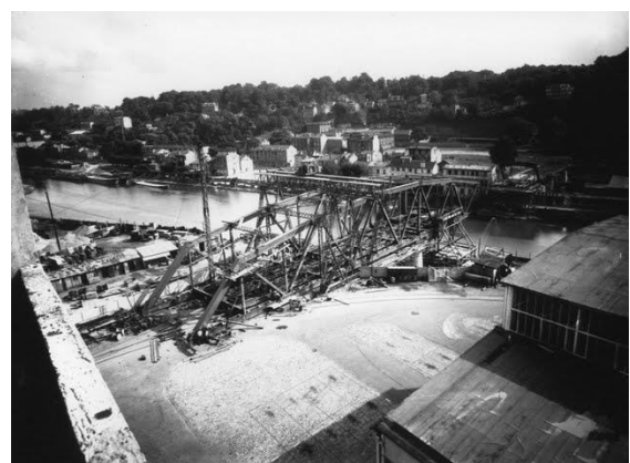
Le pont Seibert de l'île Seguin à la rive de Meudon.
