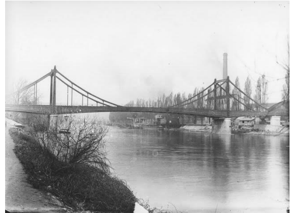
Le pont Daydé de Billancourt à l'île Seguin.
